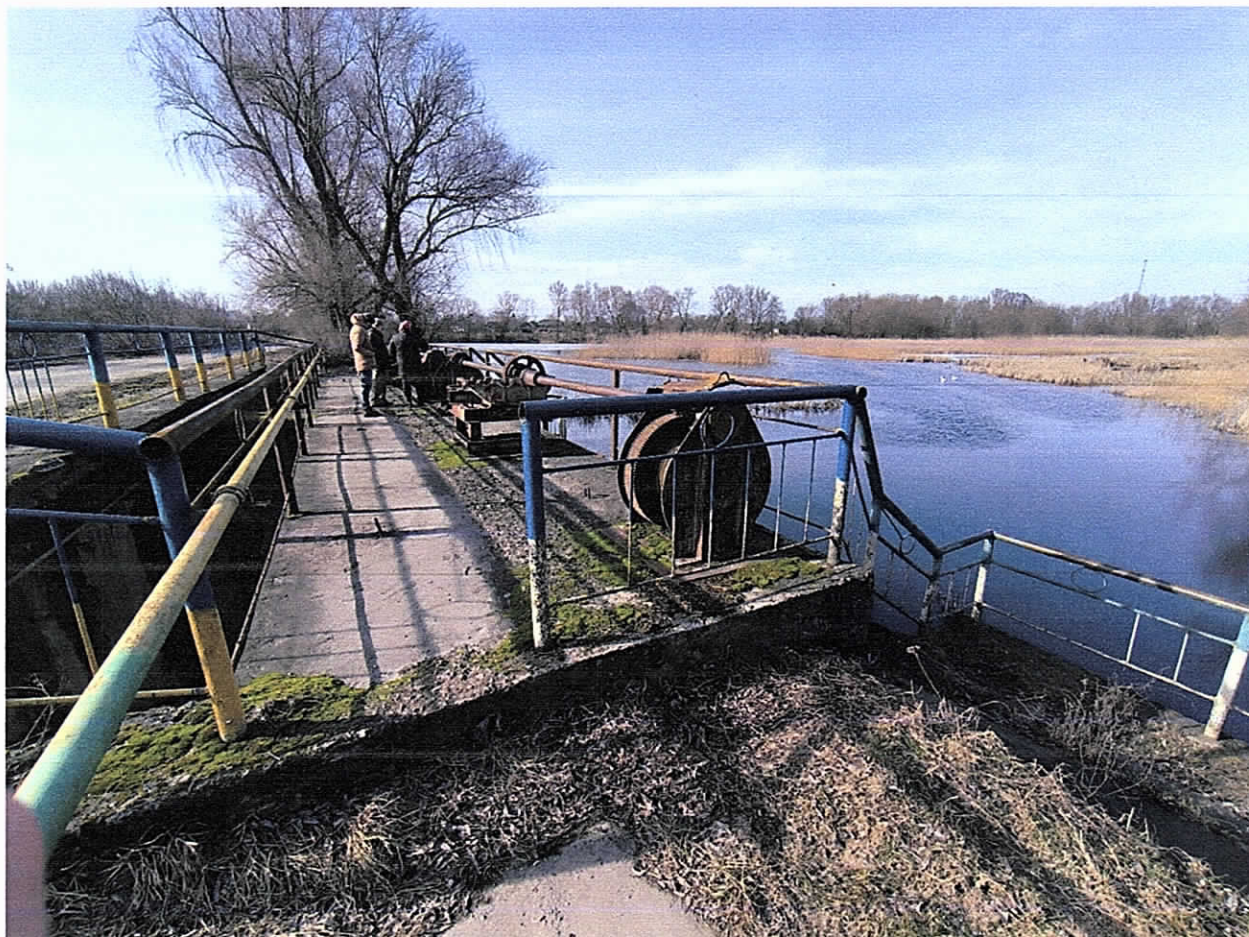
Технічний стан_Шлюз-регулятор_р.Мена_с.Феськівка_Верхній б'єф_Вид на ГТС
